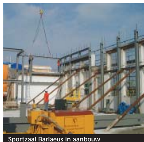
Sportzaal Barlaeus in aanbouw
